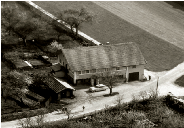
Der „Kistler“ ca. 1955 4 . Links der überdachte Eingang zum Lagerkeller.
