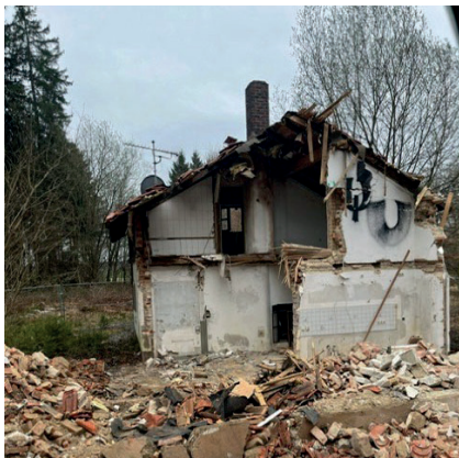
Beim Abbruch des „Forsthauses“ am 15.04.22
