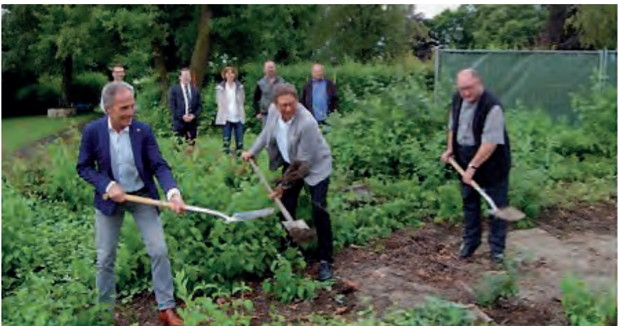
Mit einem Spatenstich, am Donnerstag, den 16.07.2020, wurden die Bauarbeiten offiziell begonnen. Mit dabei (im Bild v. li.): 1. Bürgermeister Andreas Lutz, Architekt Hans Baumann und Pfarrer Pater Egino.
